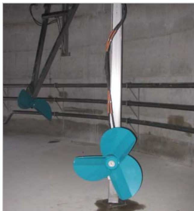
Vzhledem k nebezpečí výbuchu je lepší používat hydraulicky poháněná čerpadla Foto Karel Stober
